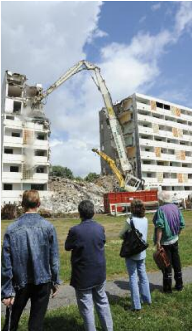
La déconstruction de la résidence Branly B s'est achevée cet été.
