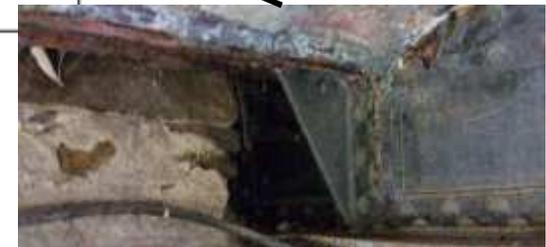
Corrosion des poutres acier
