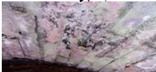
Fissures et dégradation des voûtains en brique
