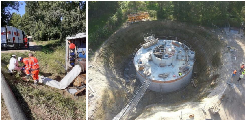
Illustrations d'interventions sur des réseaux d'eaux usées © La Roche-sur-Yon Agglomération
