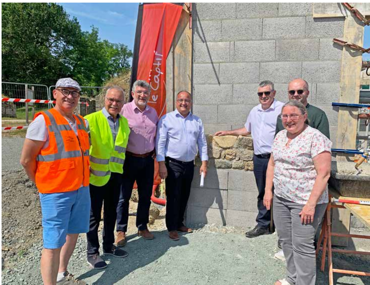
La première pierre du futur logis du domaine de Beaupuy à Mouilleron-le-Captif a été posée le 30 mai dernier.
